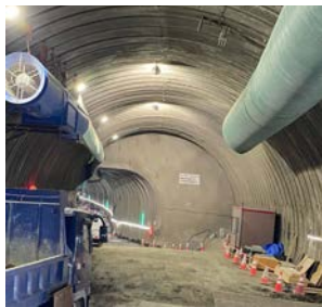
桂台トンネル内部
