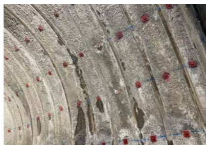
NATMナトム工法 掘削と同時に吹付コンクリートで地山の安定を図る。
