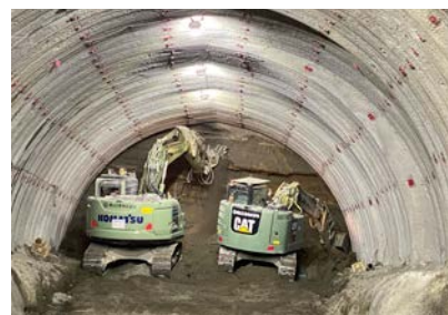
NATMナトム工法 掘削と同時に吹付コンクリートで地山の安定を図る。
