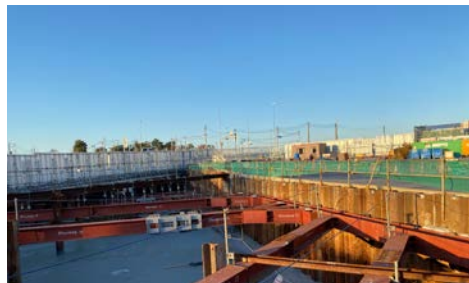
戸塚IC工事(前方が国道1号線)
